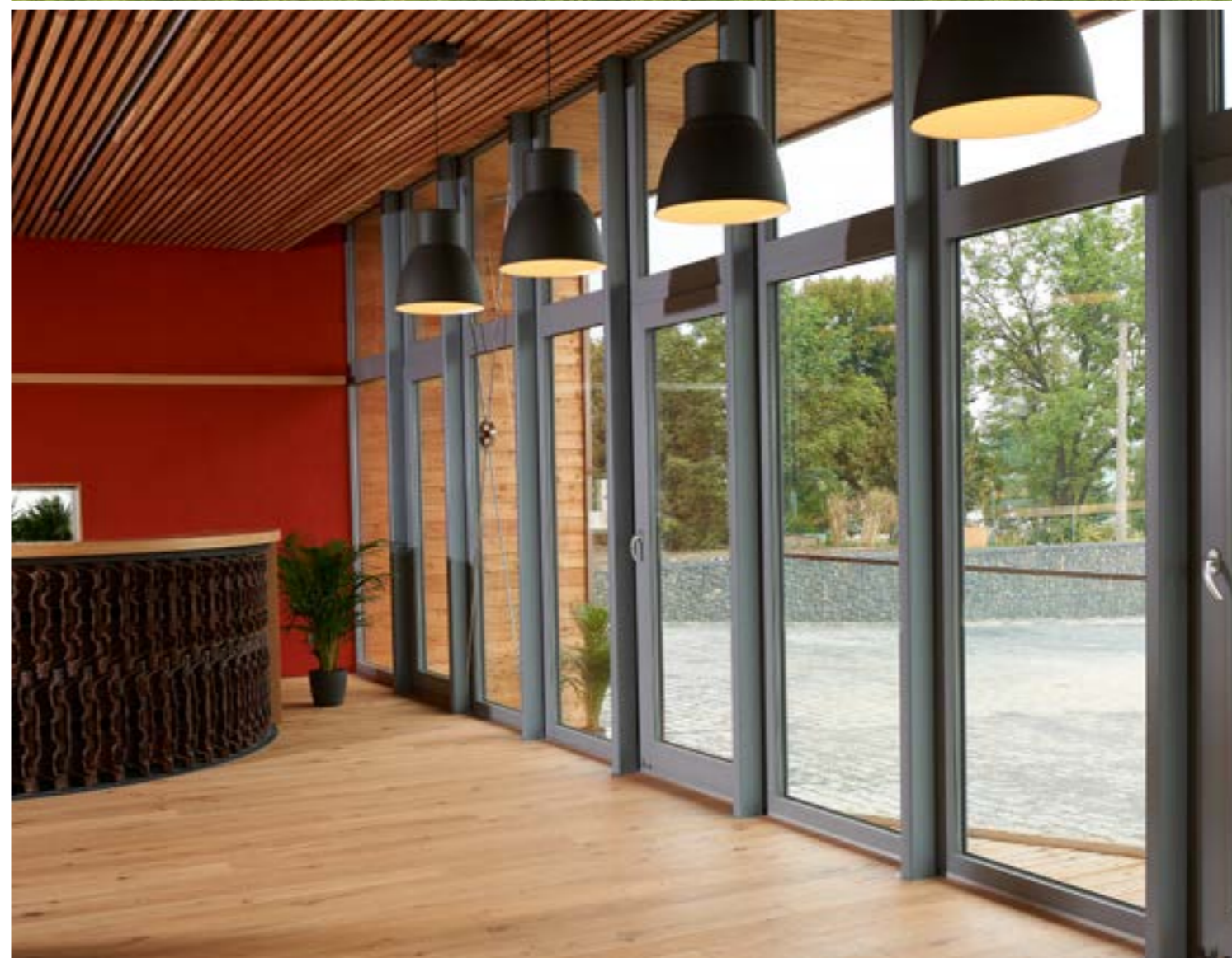
Pivovar Zichovec, Louny V moderním pivovarském provozu jsme realizovali dodávku a montáž oken a vstupní vchodové stěny kotvené do speciální ocelové konstrukce (2015).
